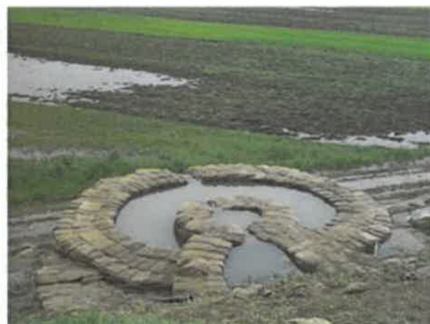
5. sz. képcsoportok: A buzgár kiépített ellennyomó medencéje
