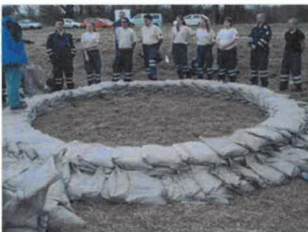
6. sz. képcsoportok: A buzgár ellennyomó medencéjének kiépítése
