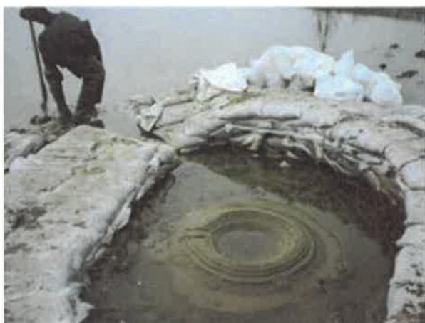
5. sz. képcsoportok: A buzgár kiépített ellennyomó medencéje
