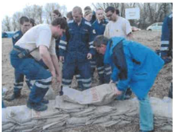
6. sz. képcsoportok: A buzgár ellennyomó medencéjének kiépítése
