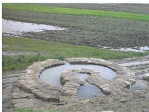
5. sz. képcsoportok: A buzgár kiépített ellennyomó medencéje
