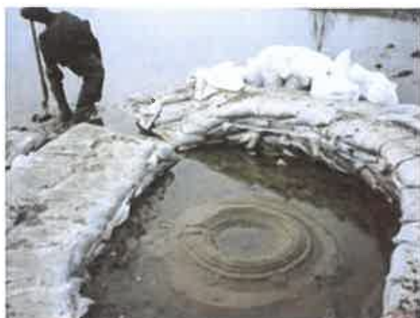
5. sz. képcsoportok: A buzgár kiépített ellennyomó medencéje
