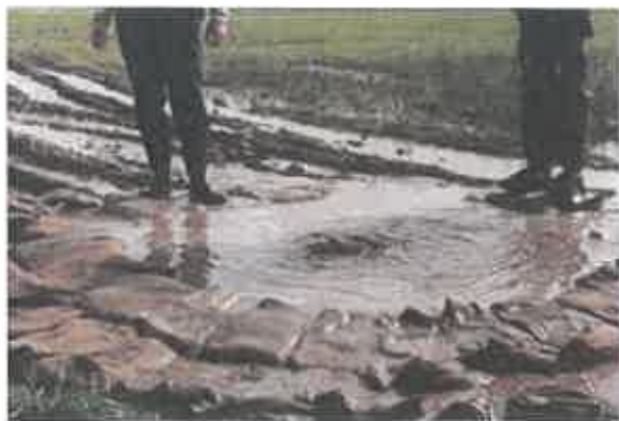
3. sz. kép: Buzgár közvetlenül a felfedezése után
