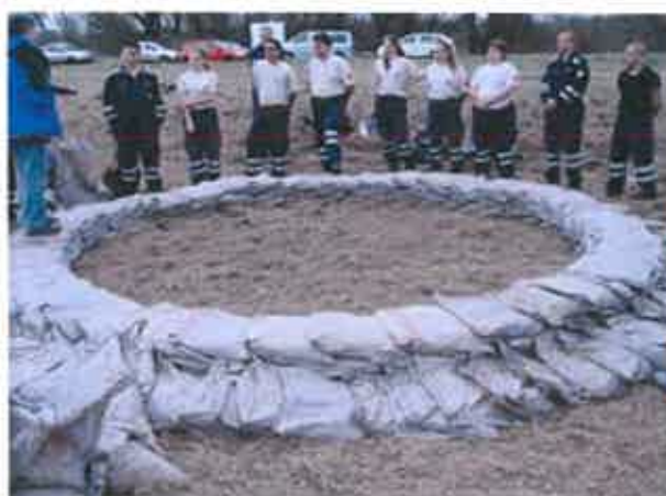
6. sz. képcsoportok: A buzgár ellennyomó medencéjének kiépítése
