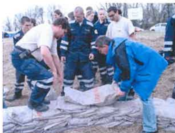
6. sz. képcsoportok: A buzgár ellennyomó medencéjének kiépítése
